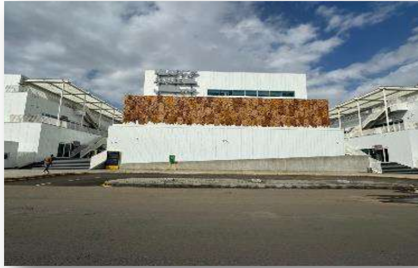
صورة رقم (١٥) يظهر فيها العمل (الخلية) بعد الانتهاء من تركيب واجهة المبنى - ٢٠٢٣
